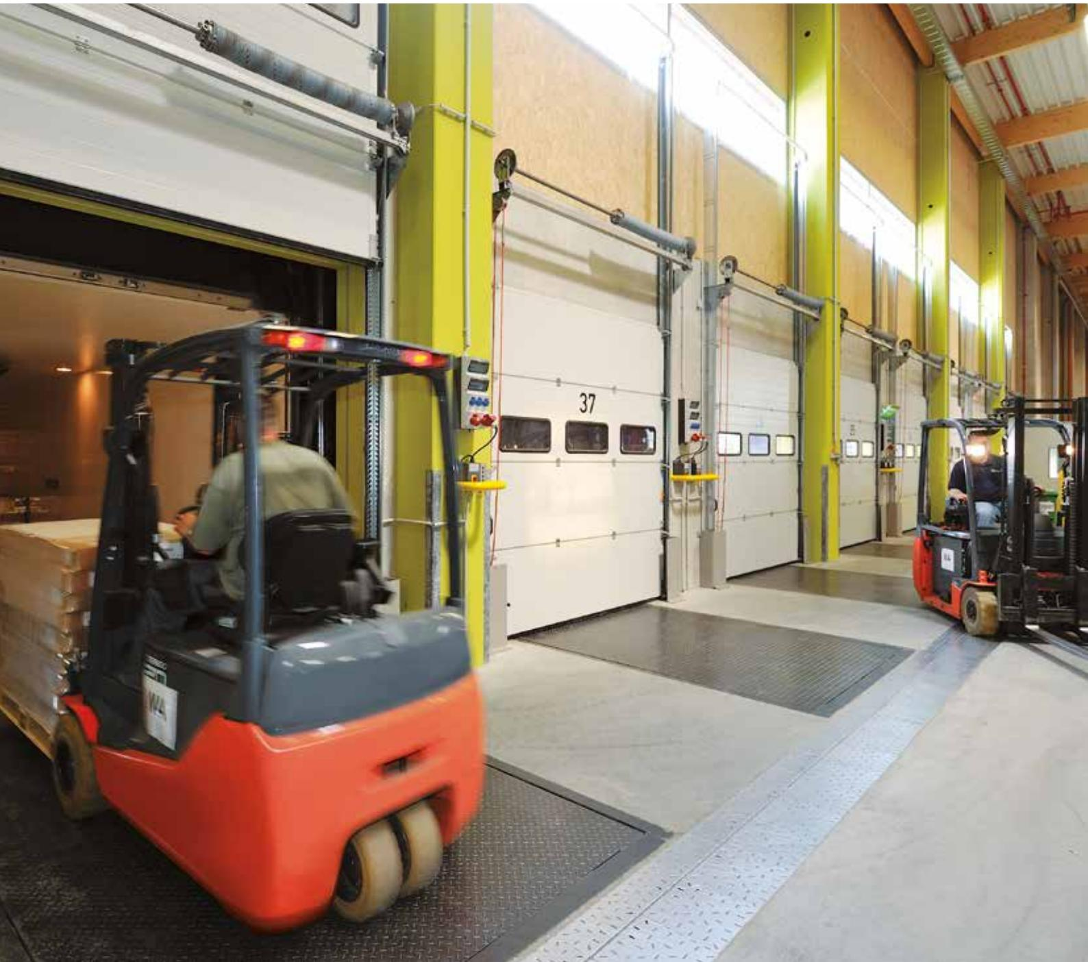
Гидравлические перегрузочные мосты поставляются с откидной или выдвижной аппарелью. Благодаря их длине до 5 м они перекрывают большие перепады высоты между рампой и погрузочной платформой грузовика. При этом платформа перегрузочного моста изготовлена как цельное изделие размером до 2000 × 3000 мм. Платы более широких и длинных перегрузочных мостов тщательно соединены сплошным, стабильным сварным швом.
